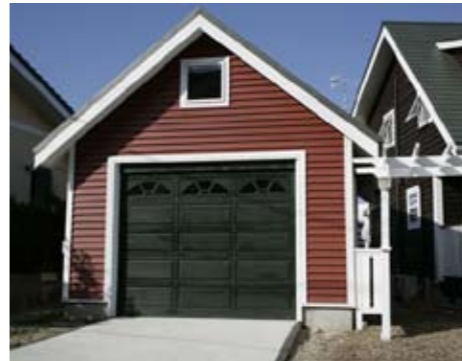
ガレージドアやドア枠、破風板などの塗装は中西さんの手によるもの。「うまく塗るのに手こずったし、何回も塗るのはかなり体力を消耗しました」と笑う
